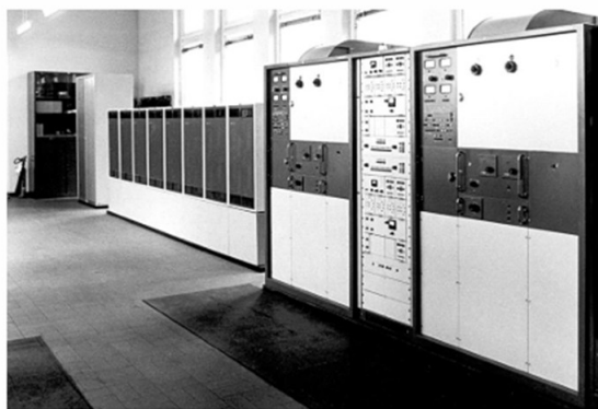
Links: VHF-zenders Rechts: middengolf enkelzijbandtelefoniezenders Philips RZ520 met hun voormodulatie-apparaat.
