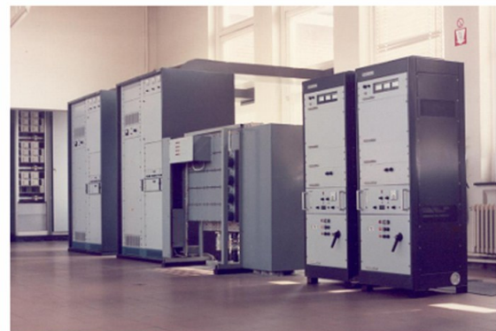
Links: middengolftelegrafiezenders Midden: coaxiale feederschakelaar Rechts: middengolf enkelzijaandelefoniezenders Philips 1 kW
